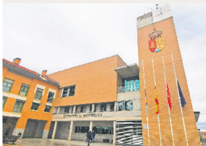
Panorámica del Ayuntamiento de Arroyomolinos
