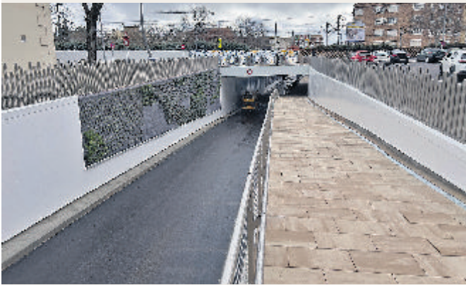
Imagen del paso subterráneo (foto: Ayuntamiento de Fuenlabrada)
