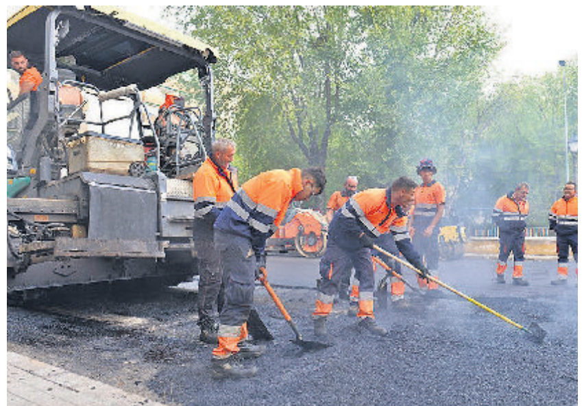
Operarios trabajan durante un plan de asfaltado anterior
