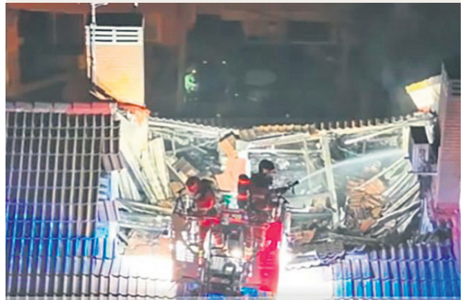
Imagen de los bomberos actuando sobre la cubierta de la vivienda
