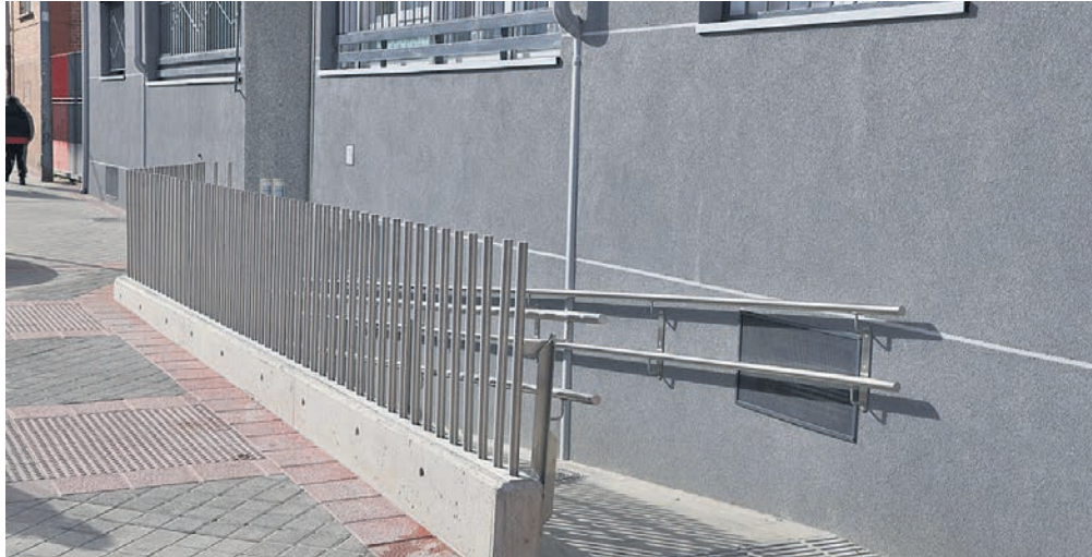
Rampa en Fuenlabrada
