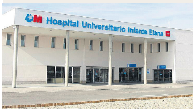
Panorámica del acceso principal del Hospital Infanta Elena
