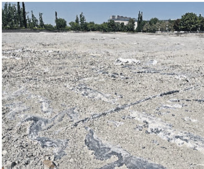
Las obras las ejecutará la empresa municipal de servicios Aserpinto
