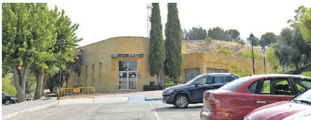
Las instalaciones fueron revisadas por una empresa especializada que emitió informe favorable el 19 de septiembre
