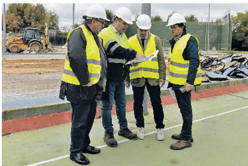
El alcalde, durante su visita a las obras del Polideportivo Municipal (foto: Ayto Valdemoro)
