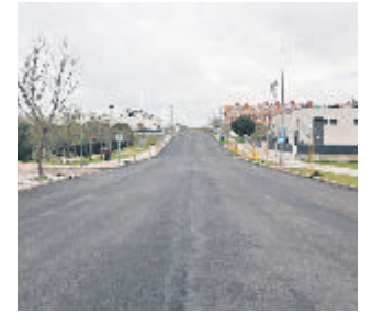
Una de las vías asfaltadas
