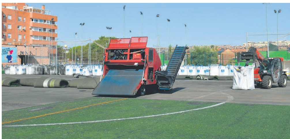
Las máquinas trabajan en la renovación de la superficie de césped artificial
