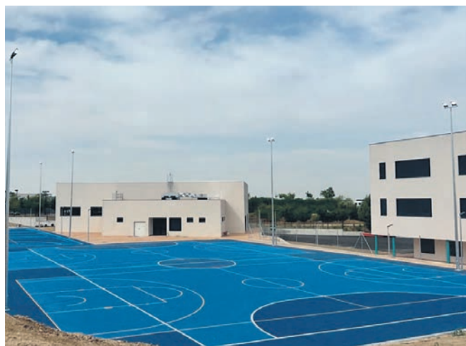
Pista exterior y parte de las instalaciones del IES Torcuato Fdez Miranda
