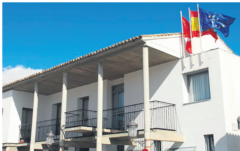
Exteriores del edificio del Ayuntamiento de Valdemoro
