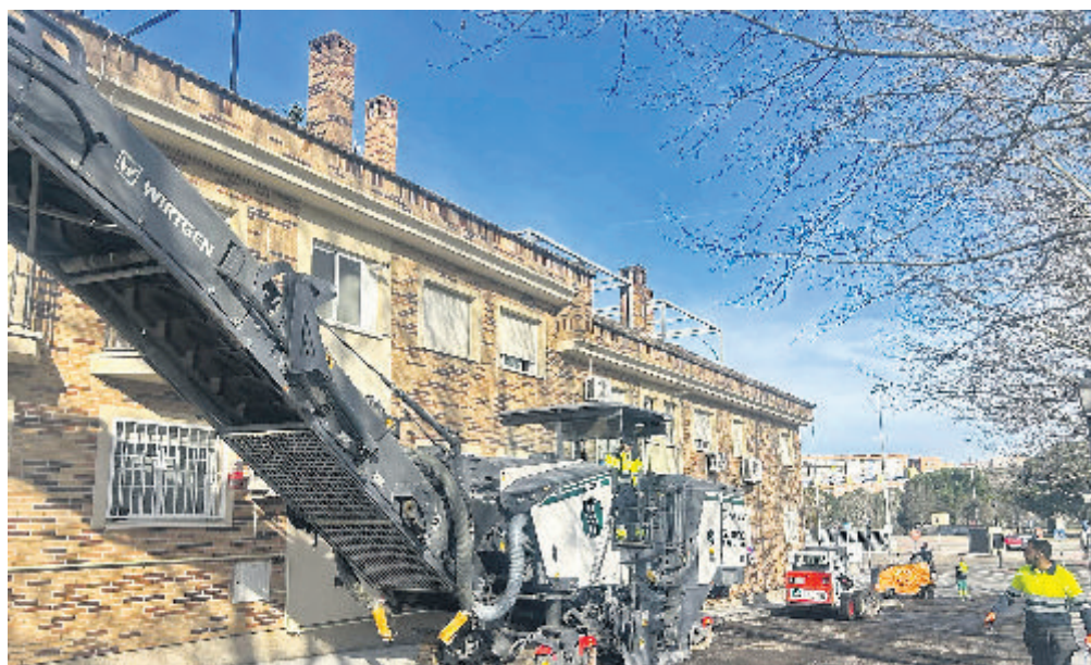
Las máquinas ya trabajan en distintas calles del municipio (foto: Ayto Arroyomolinos)
