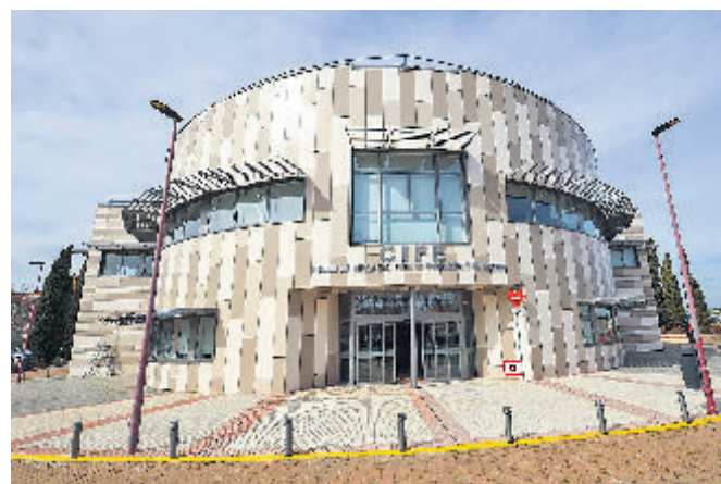
Fachada del CIFE, donde se realizará la formación técnica
