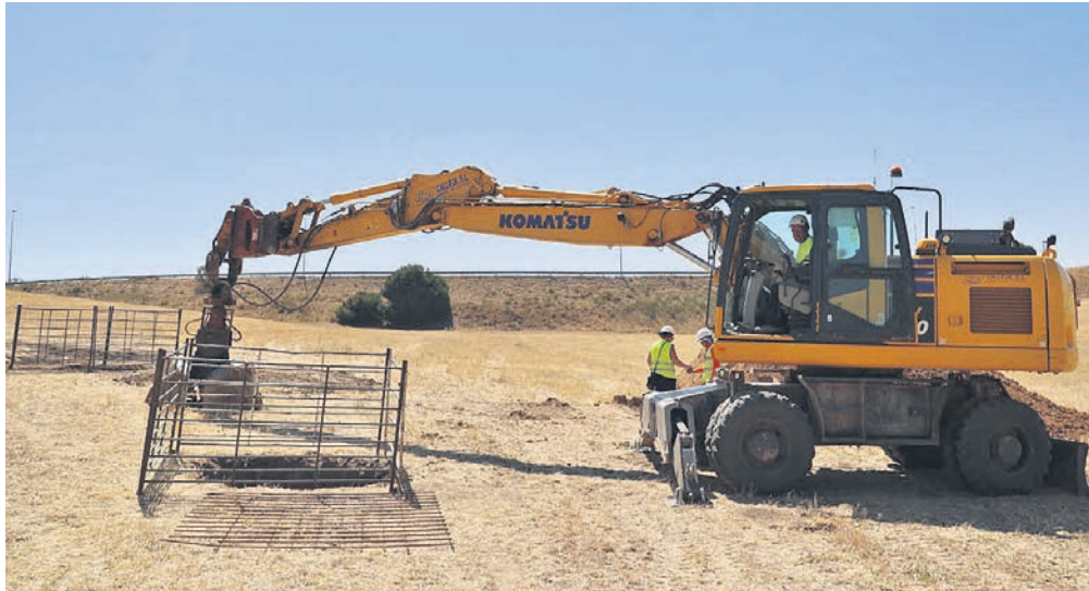
Las máquinas ya trabajan en la primera fase de los trabajos (foto: Ayto Arroyomolinos)
