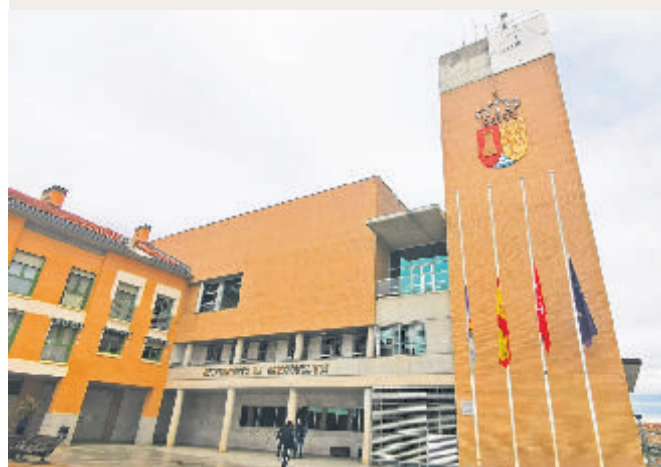
Panorámica del Ayuntamiento de Arroyomolinos
