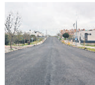
Una de las vías asfaltadas
