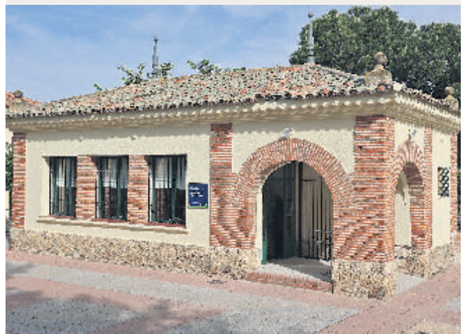
El edificio de las antiguas escuelas es ahora centro de educación ambiental
