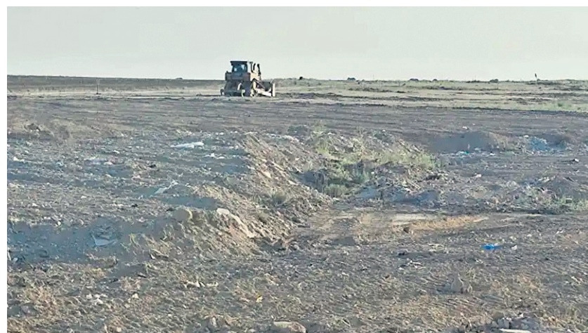
Imagen de la zona afectada
