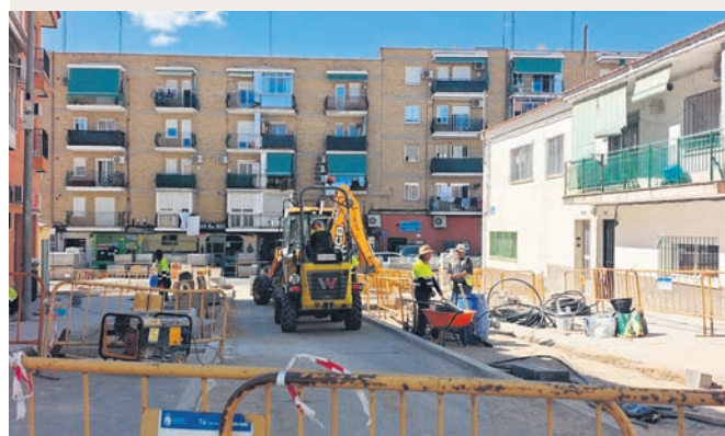
Imagen de la zona en la que se está trabajando
