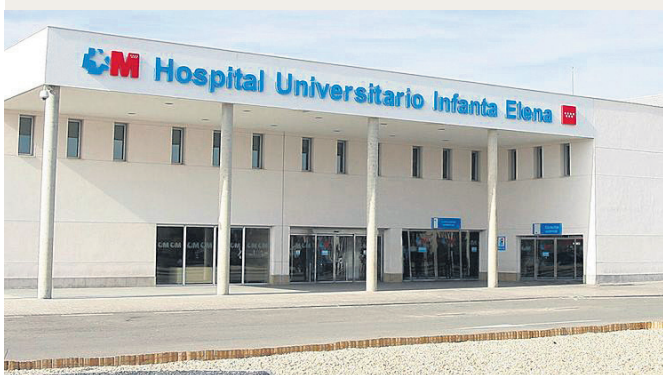
Panorámica del acceso principal del Hospital Infanta Elena
